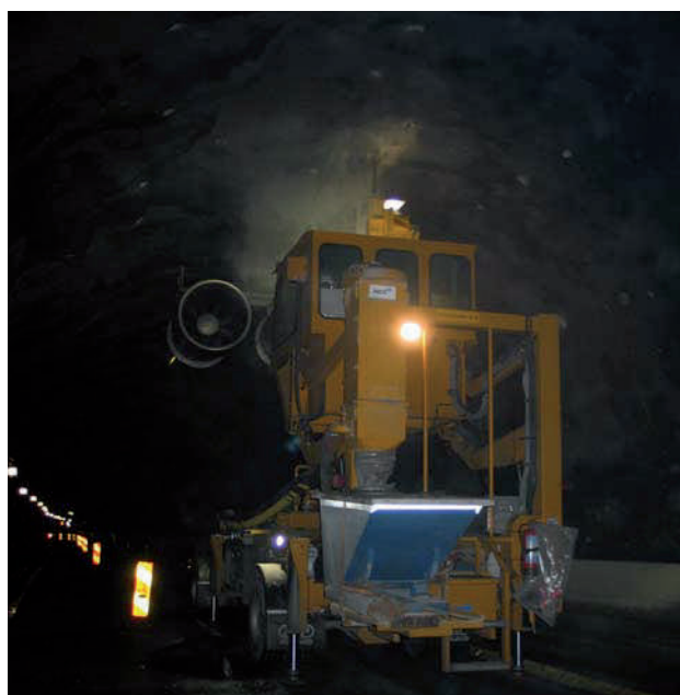
Figur 6 Boring med Essverk-rigg
