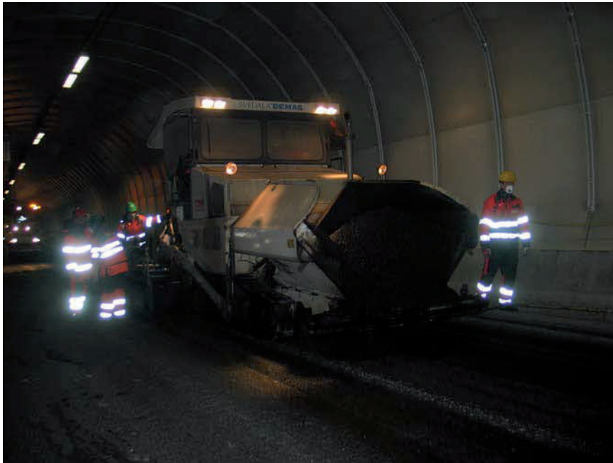
Figur 9 Asfaltering av veibanen med asfaltlegger av typen Demag Df 135C
