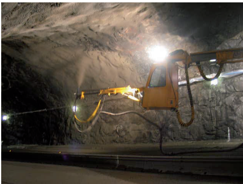
Figur 18 Betongsprøyting
