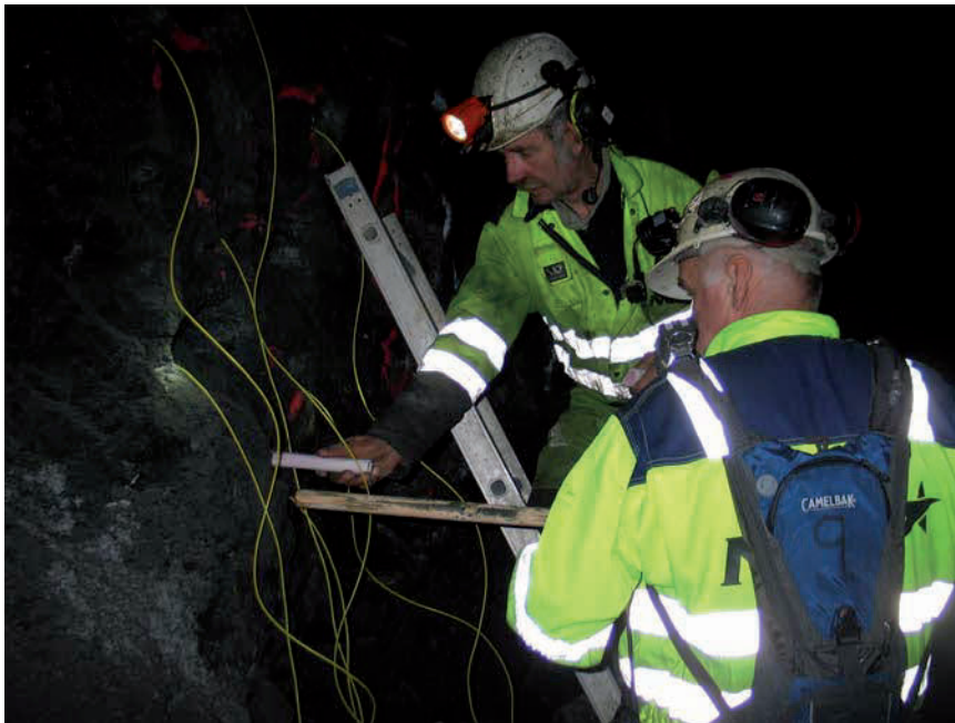
Figur 4 Ladning av sprengstoff
