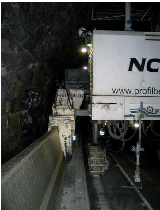
Figur 2 Glidestøp av rekkverk
