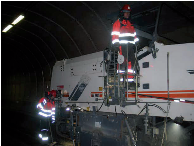
Figur 8 Asfaltfresing med fører(øverst) og styrer
