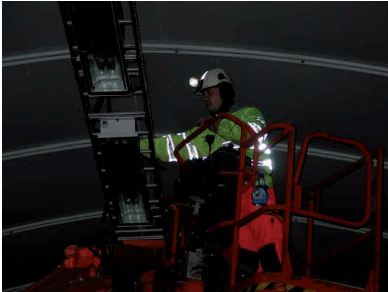
Figur 17 Montering av belysning
